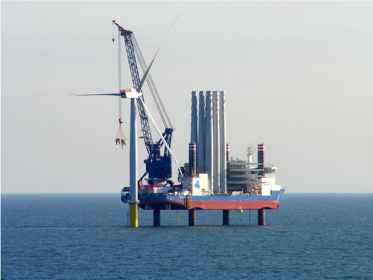
Sea Installer under montage af havvindmølle (før montage af helikopterdæk og forlængelse af kranarm)
